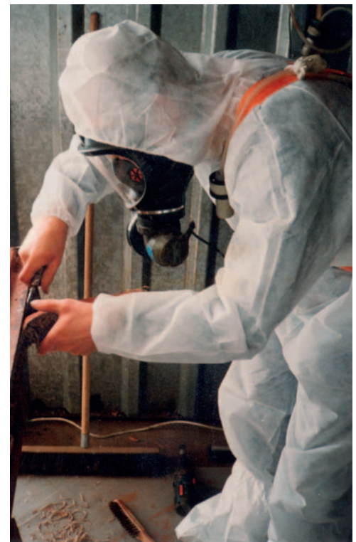
Dieser Mann arbeitet geschützt nach der Technischen Regel für Gefahrstoffe 519 „Asbest: Abbruch-, Sanierungs- und Instandhaltungsarbeiten“.
