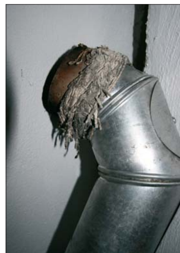
... oder der Asbestschnur zur Abdichtung am Kaminrohr...
